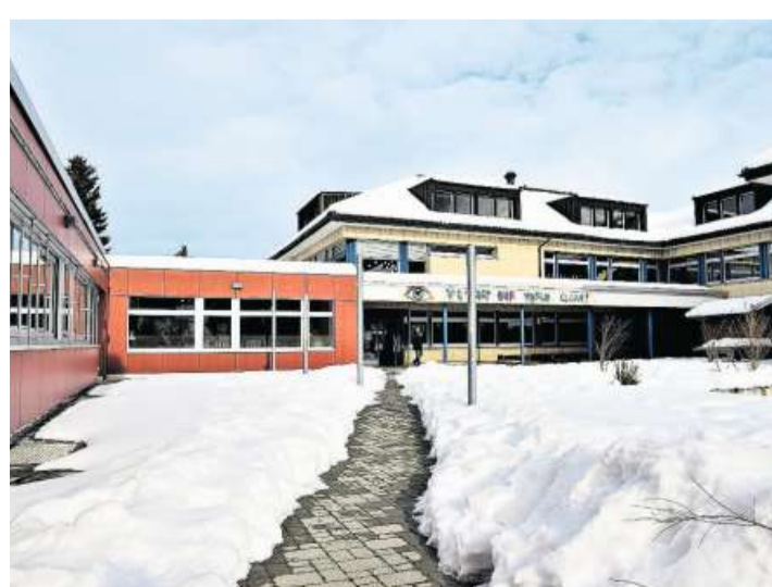
Blick in den verschneiten Innenhof der Balterswiler Sekundarschulanlage Lützelalmurg.
